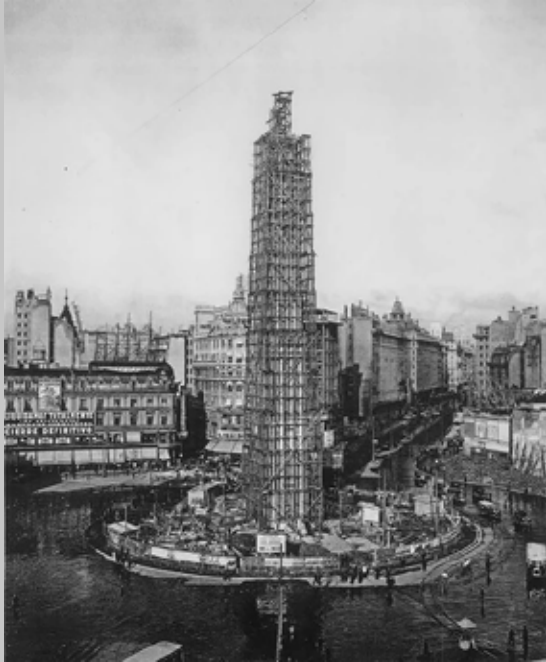
EL OBELISCO EN CONSTRUCCIÓN 1936
